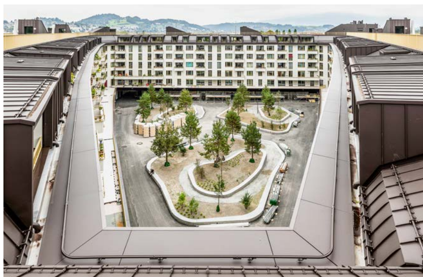
Wegen der darunterliegenden Einstellhalle ist der Wurzelraum für die Hofbepflanzung beschränkt. Der Landschaftsarchitekt setzte deshalb auf eine Bergflora – die drei Erhebungen nehmen darauf Bezug.
