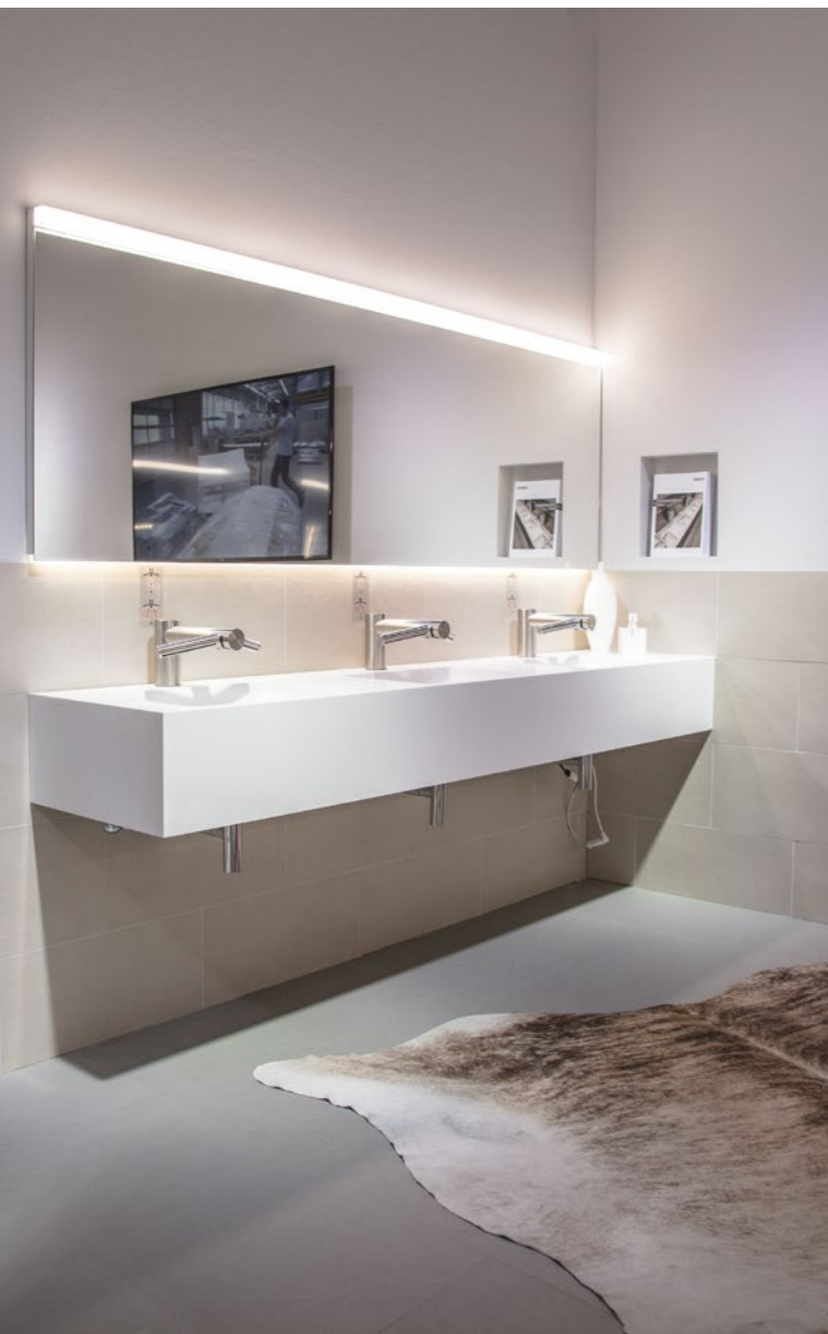
In Hochdorf stellt Talsee die individuellen Waschtische her und baut auch die Dyson-Technologie direkt in die Waschtischbänke ein, sodass die Module auf der Baustelle nur noch festgeschraubt und an Wasser und Strom angeschlossen werden müssen.
